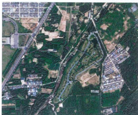
▼秦岭违建别墅拆除前后卫星遥感影像 (左: GF-2, 2016 年 6 月; 右: GF-2, 2021 年 9 月)
